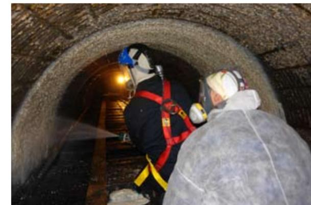
и бактерий. Монолитность полученной структуры, отсутствие полостей в покрытии и за покрытием обеспечивает полную остановку разрушительных коррозионных процессов.
