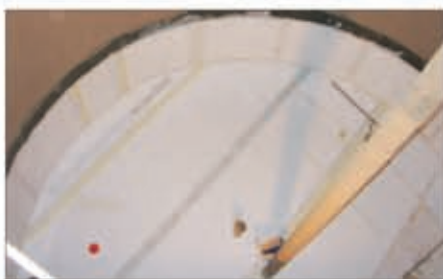
Вид емкости после нанесения покрытия
