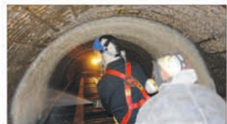
Реконструкция канализационного коллектора (г. Набережные Челны)
