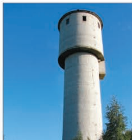
Водонапорная башня (г. Тосно)
