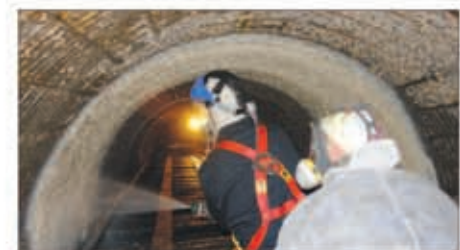
Реконструкция канализационного коллектора (г. Набережные Челны)
