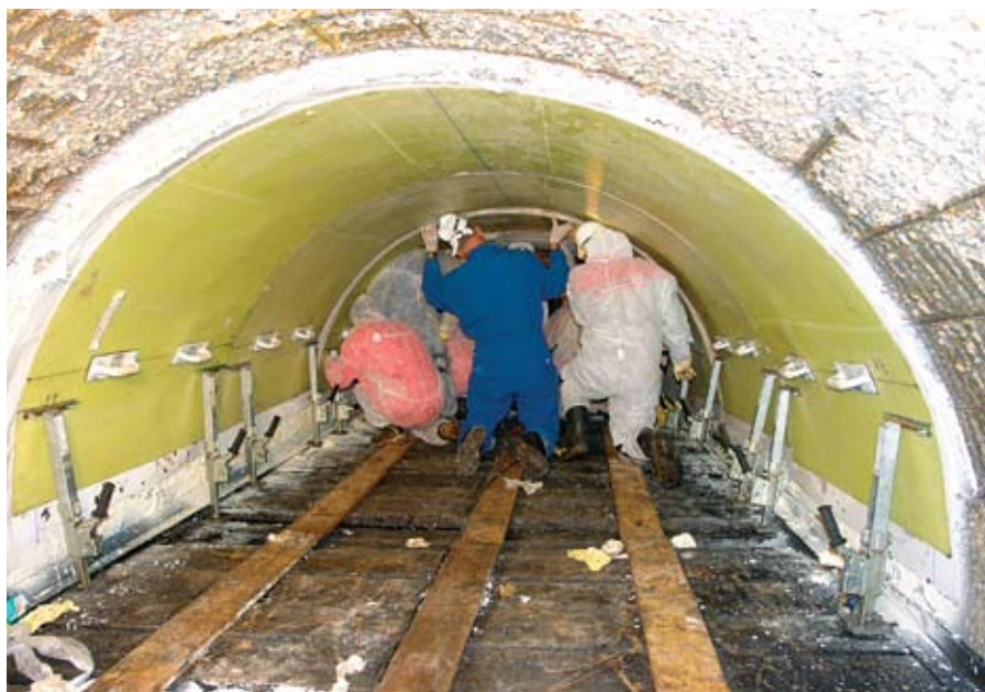
Монтаж покрытия Linabond в коллекторе
