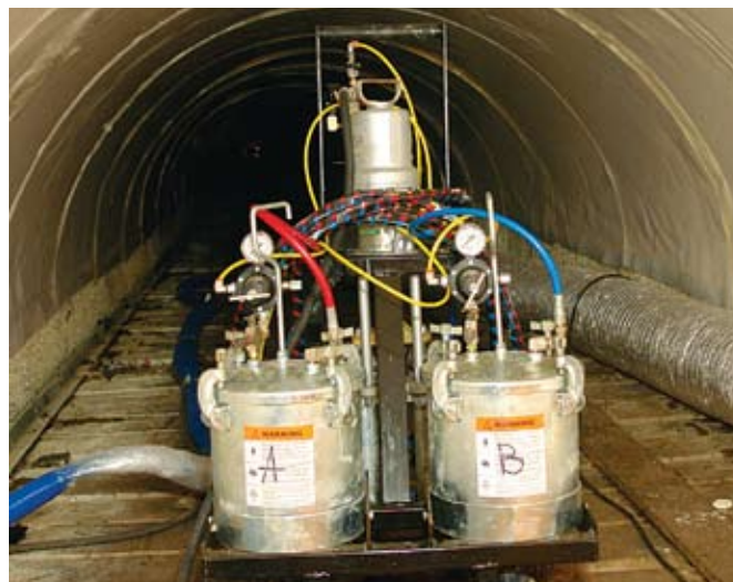
Оборудование для нанесения полимера для швов
