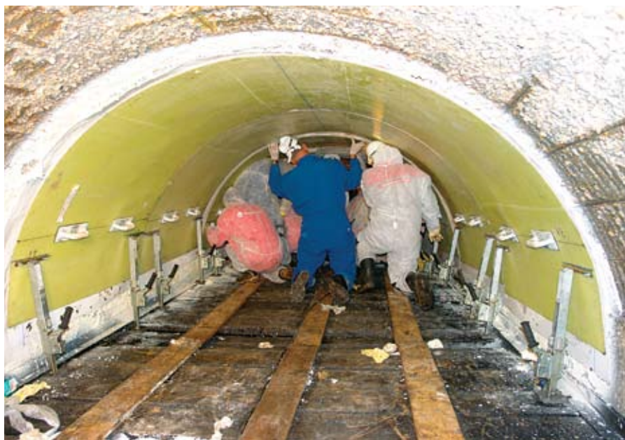
Монтаж покрытия Linabond в коллекторе
