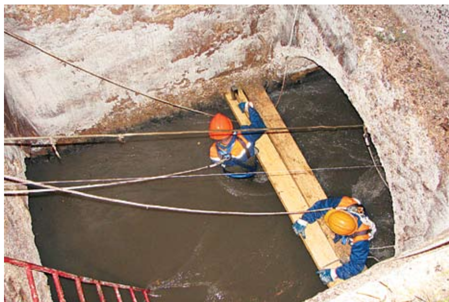
Начало выполнения работ в условиях действующего коллектора
