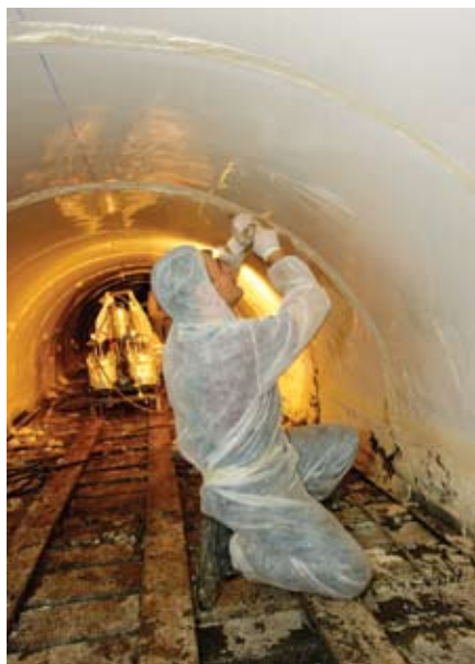
Выполнение стыков листов ПВХ
