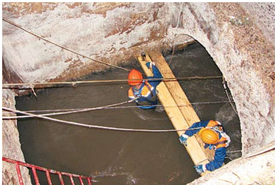
Начало выполнения работ в условиях действующего коллектора
