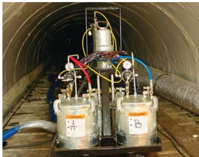
Оборудование для нанесения полимера для швов
