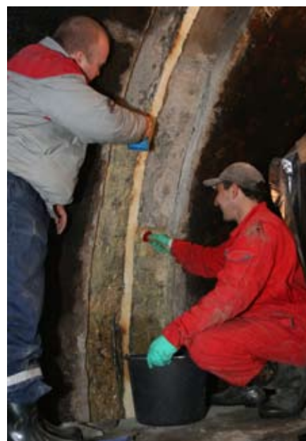
Грунтовка одного шва праймером занимает около 20 мин
