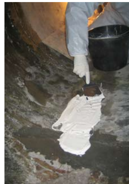
Нанесение полимера Linabond SP Mastic (Акуловский водовод)
