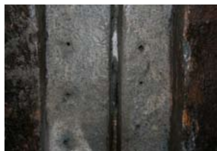
На подготовку швов к нанесению покрытия уходит 1 день
