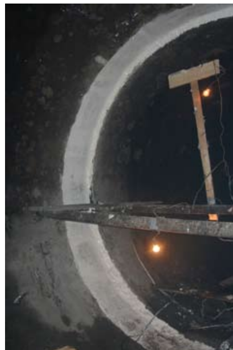
Стык на Акуловском водоводе с нанесенным покрытием Linabond
