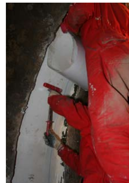
Наклеивание полужестких листов ПВХ – 30 мин на один шов
