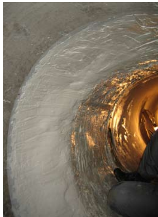
Стык в чугунной трубе с нанесенным покрытием Linabond
