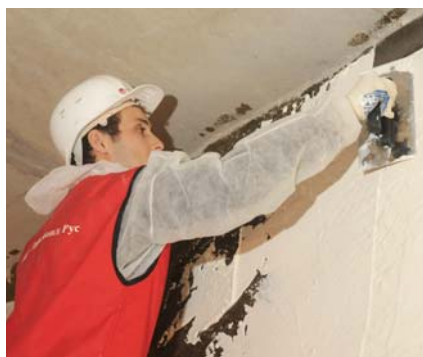
Выполнение работ по технологии Линабонд
