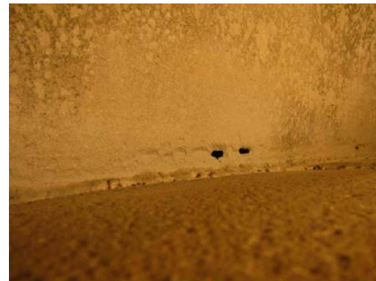
Сквозная коррозия стенок, сварных швов и дна резервуара
