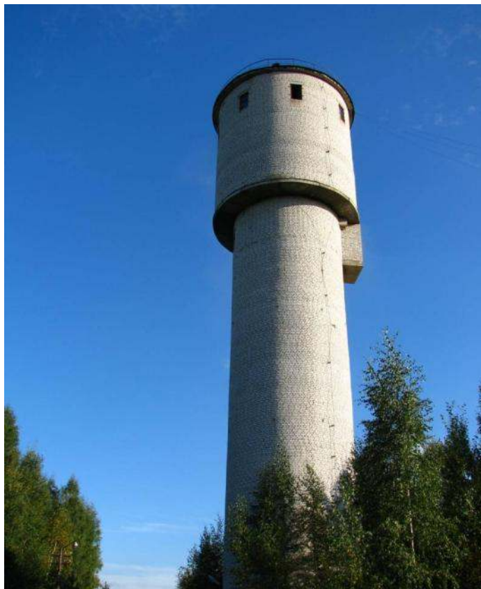
Водонапорная башня (вид снаружи)
