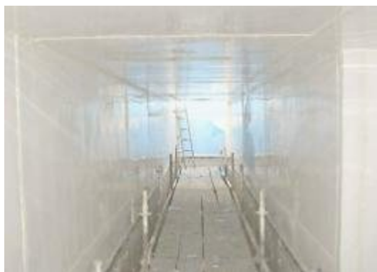
Канализационные насосные станции
