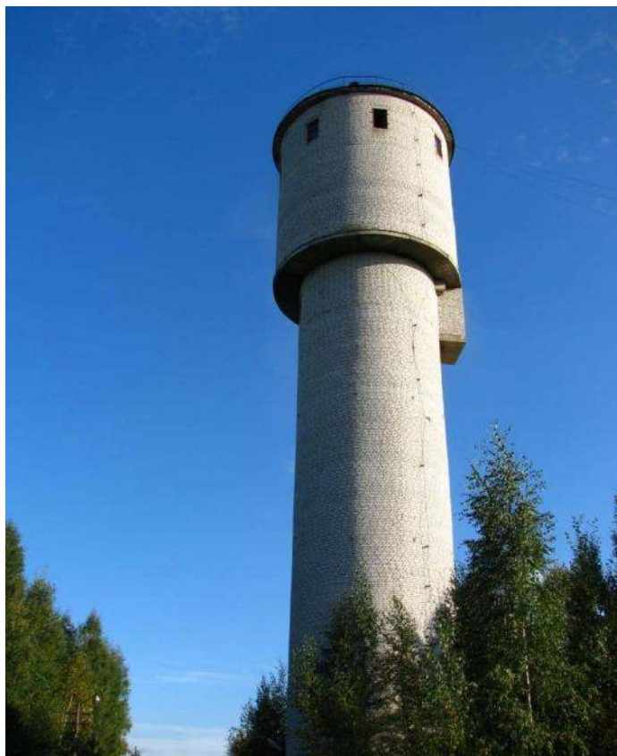
Водонапорная башня (вид снаружи)
