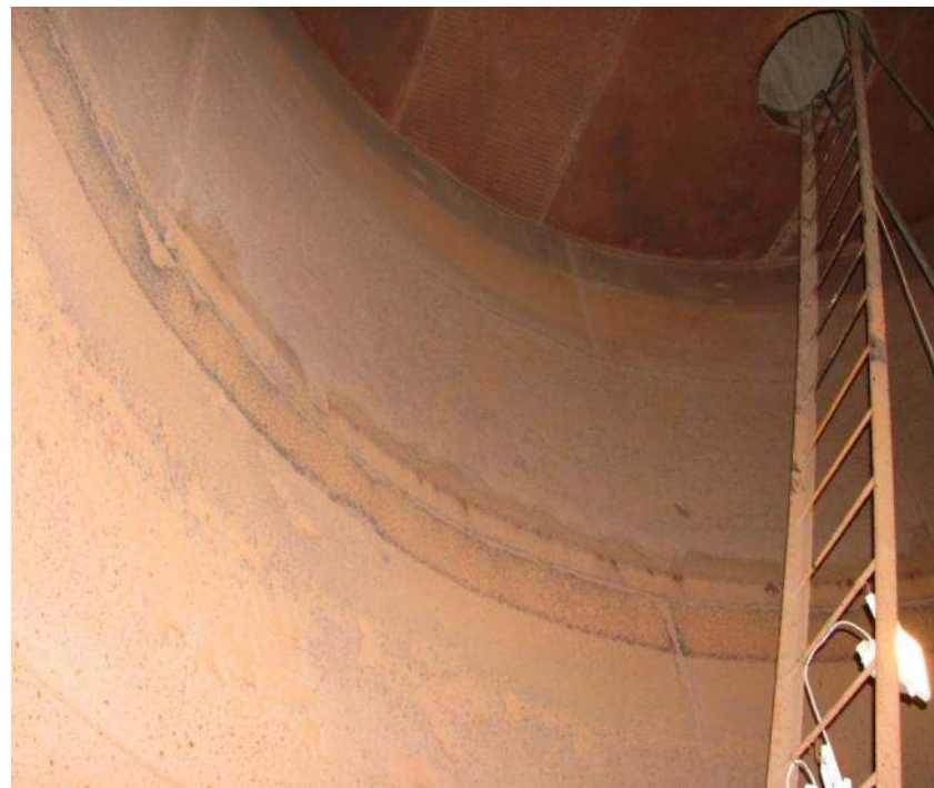
Стальная емкость водонапорной башни (вид внутри)
